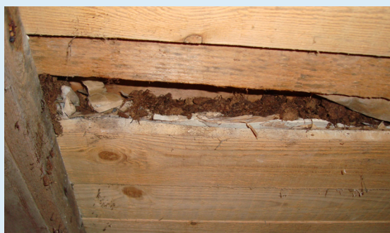
Gulv over krybekælder isoleret med 30 mm tørvelag.
