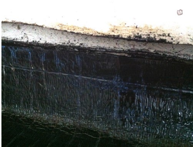
Billede 10. Bitumenmembranen føres til udsparring (t.v.) og tilsluttes den vandrette fugtspærre (t.h.) ved at udfylde udsparringen i pudslaget med passende fugemasse.
