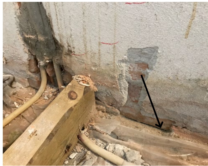
Billede 5. Vandret fugtspærre pudset ind bag henholdsvis facadepuds (t.v.) og bag indvendigt pudslag (t.h.) med vægevirkning og opstigende grundfugt til følge.
