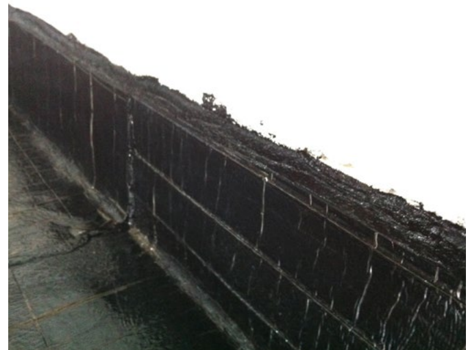
Billede 10. Bitumenmembranen føres til udsparring (t.v.) og tilsluttes den vandrette fugtspærre (t.h.) ved at udfylde udsparringen i pudslaget med passende fugemasse.
