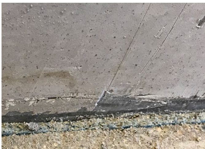
Billede 13. Radonsikring af samling mellem terrændæk og tilstødende vægge. Fugebagstop som kantstrimmel mellem terrændæk og væg (t.v.) samt smøremembran ilagt armeringsvæv, som placeres ovenpå sliptape eller fugebagstop, se billede 13. Til tætning ved gennemsørgninger af installationer kan der eventuelt anvendes elastisk fugemasse eller også smøremembraner som beskrevet ovenover. Det er ved installationsgennemføringer meget vigtigt at tage højde for rørens funktion. Ved varmerør og varmtvandsrør vil der fx være skiftende temperaturbelastninger, hvilket medfører knirken, hvis ikke der lægges en egnet bøsning omkring røret.
