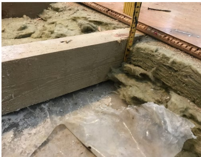
Billede 1. T.v.: Måling af isoleringstykkelsen i strøgulvkonstruktionen over terrændækket. T.h.: Søgeåbning til at undersøge opbygningen af terrændækket. Ved at øge åbningen vil det også være muligt at bestemme tykkelsen af det kapillarbrydende lag.
