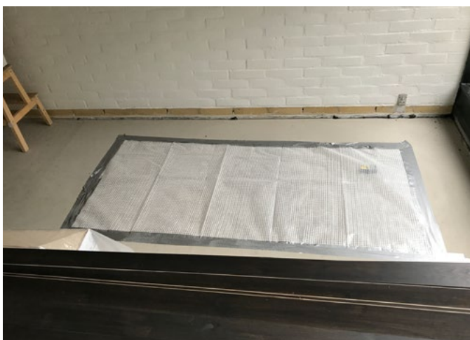
Billede 6. Vejledende kontrol af fugtniveau i betondæk inden udlægning af gulvbelægning.
