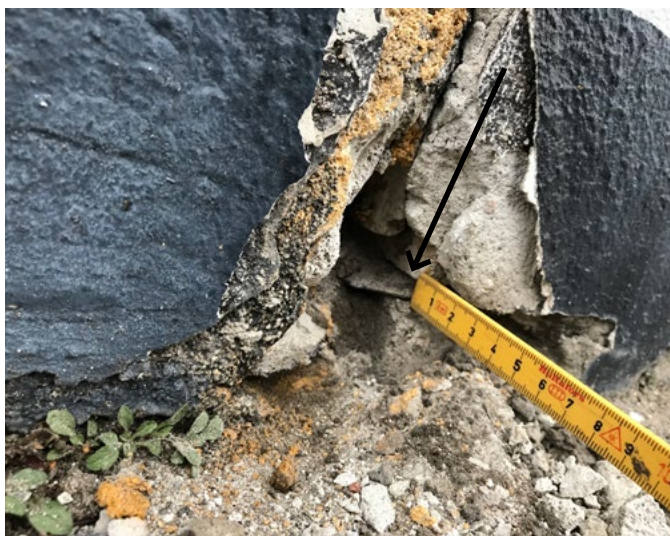
Billede 5. Vandret fugtspærre pudset ind bag henholdsvis facadepuds (t.v.) og bag indvendigt pudslag (t.h.) med vægevirkning og opstigende grundfugt til følge.
