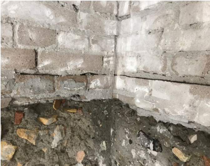
Billede 9. Fritlæggelse af vandret fugtmembran (t.v.) og udsparring i puds (t.h.), så den vandrette fugtspærre ligger frit.
