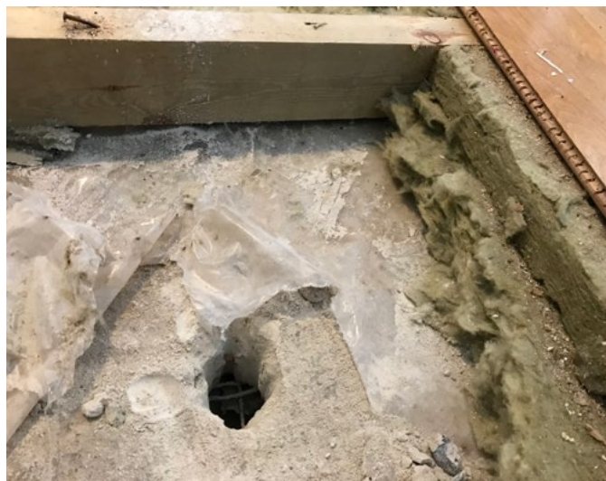
Billede 1. T.v.: Måling af isoleringstykkelsen i strøgulvkonstruktionen over terrændækket. T.h.: Søgeåbning til at undersøge opbygningen af terrændækket. Ved at øge åbningen vil det også være muligt at bestemme tykkelsen af det kapillarbrydende lag.
