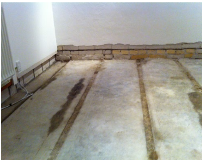
Billede 2. T.v.: Ingen isolering under terrændækket, som er ca. 10-12 cm tykt, armeret og af en ret høj styrke. Det kapillarbrydende lag er singles. T.h.: Tilkald en fugtkyndig person, hvis der er tegn på fugt i det eksisterende betondæk.
