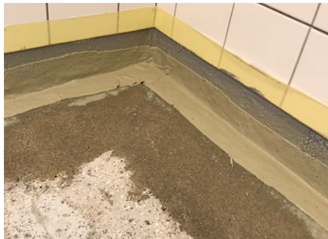
Billede 13. Radonsikring af samling mellem terrændæk og tilstødende vægge. Fugebagstop som kantstrimmel mellem terrændæk og væg (t.v.) samt smøremembran ilagt armeringsvæv, som placeres ovenpå sliptape eller fugebagstop, se billede 13. Til tætning ved gennemsørgninger af installationer kan der eventuelt anvendes elastisk fugemasse eller også smøremembraner som beskrevet ovenover. Det er ved installationsgennemføringer meget vigtigt at tage højde for rørens funktion. Ved varmerør og varmtvandsrør vil der fx være skiftende temperaturbelastninger, hvilket medfører knirken, hvis ikke der lægges en egnet bøsning omkring røret.
