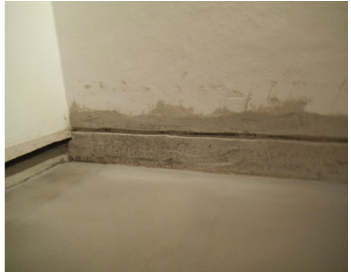
Billede 9. Fritlæggelse af vandret fugtmembran (t.v.) og udsparring i puds (t.h.), så den vandrette fugtspærre ligger frit.
