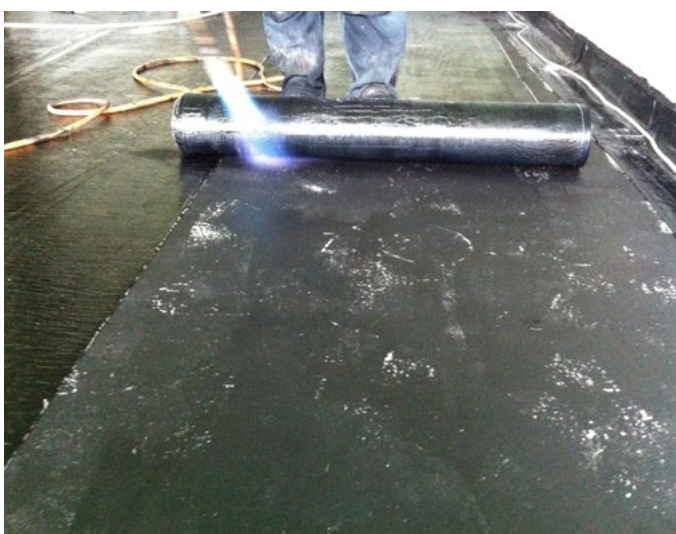
Billede 7. Udlægning af bitumenmembran. Membranen fuldsvejses til underlaget (t.v.), som skal være glat, jævnt og skimmelafrenset, og den skal eventuelt primes (følg producentens anvisninger). Lette indvendige vægge kan eventuelt ophænges eller understøttes under udlægning af membranen, så de ikke helt skal udskiftes (t.h.).
