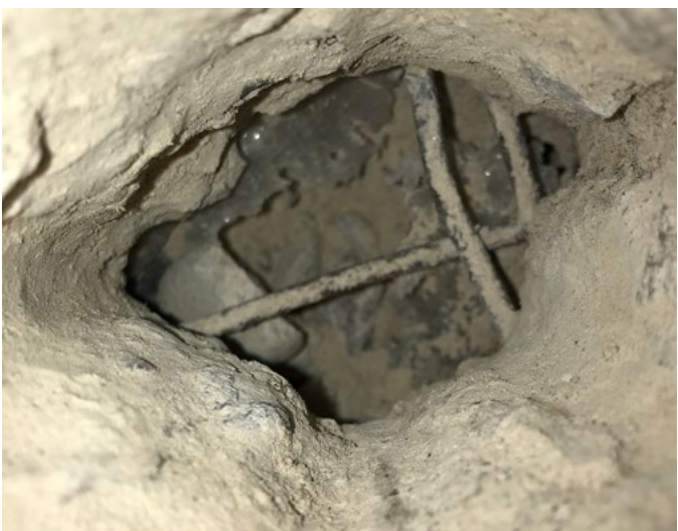
Billede 2. T.v.: Ingen isolering under terrændækket, som er ca. 10-12 cm tykt, armeret og af en ret høj styrke. Det kapillarbrydende lag er singles. T.h.: Tilkald en fugtkyndig person, hvis der er tegn på fugt i det eksisterende betondæk.
