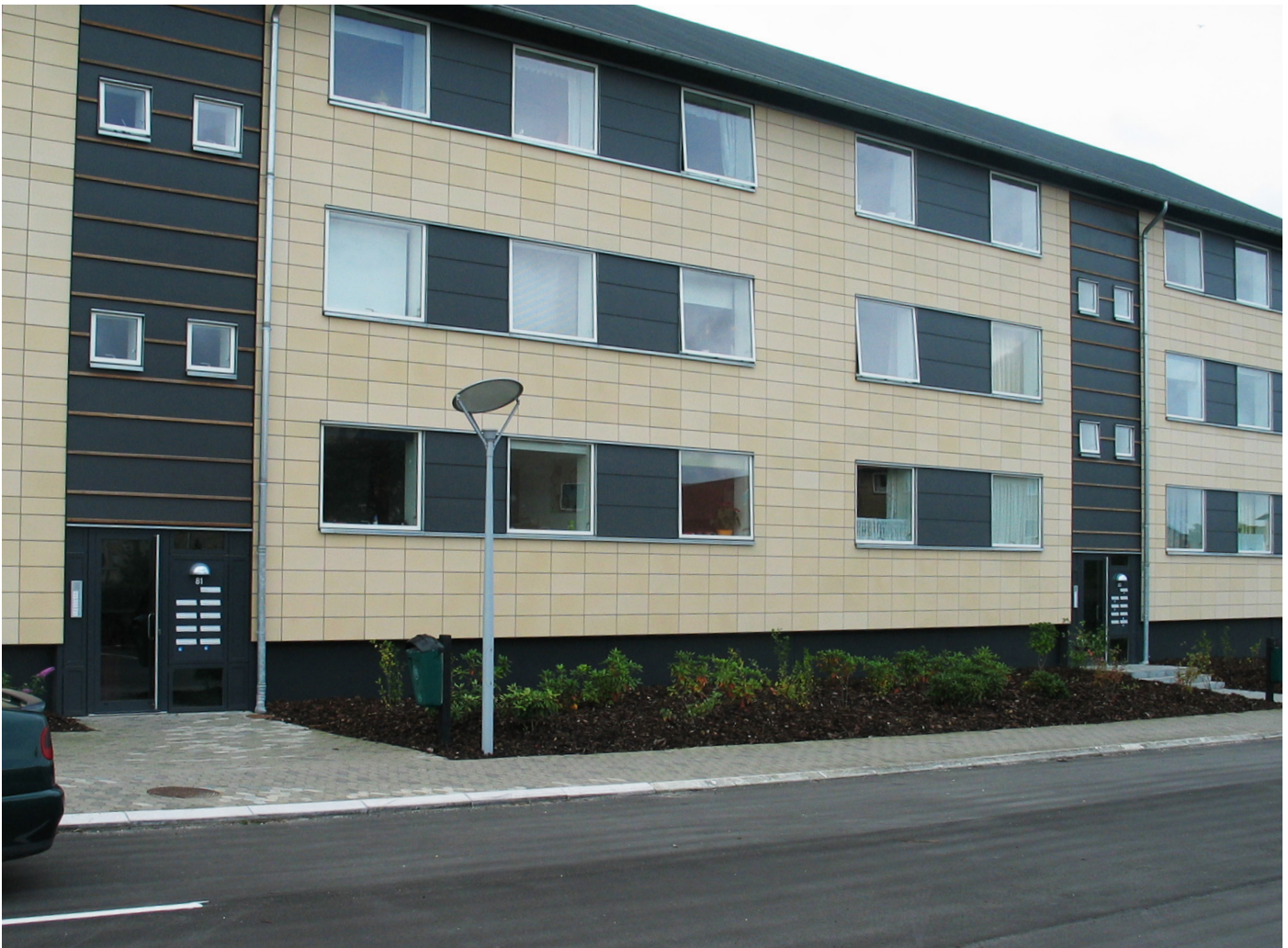
Udvendig facadeisolering med skærmtegl/fibercementplader
