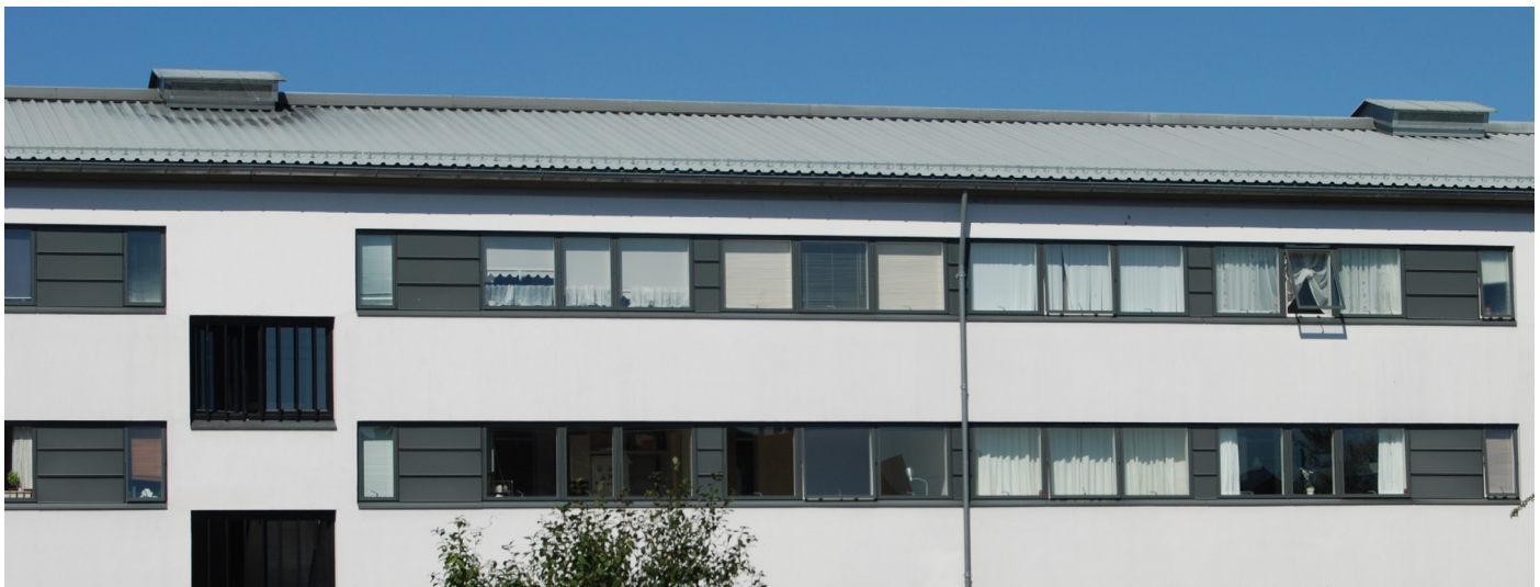
Udvendig facadeisolering med puds
