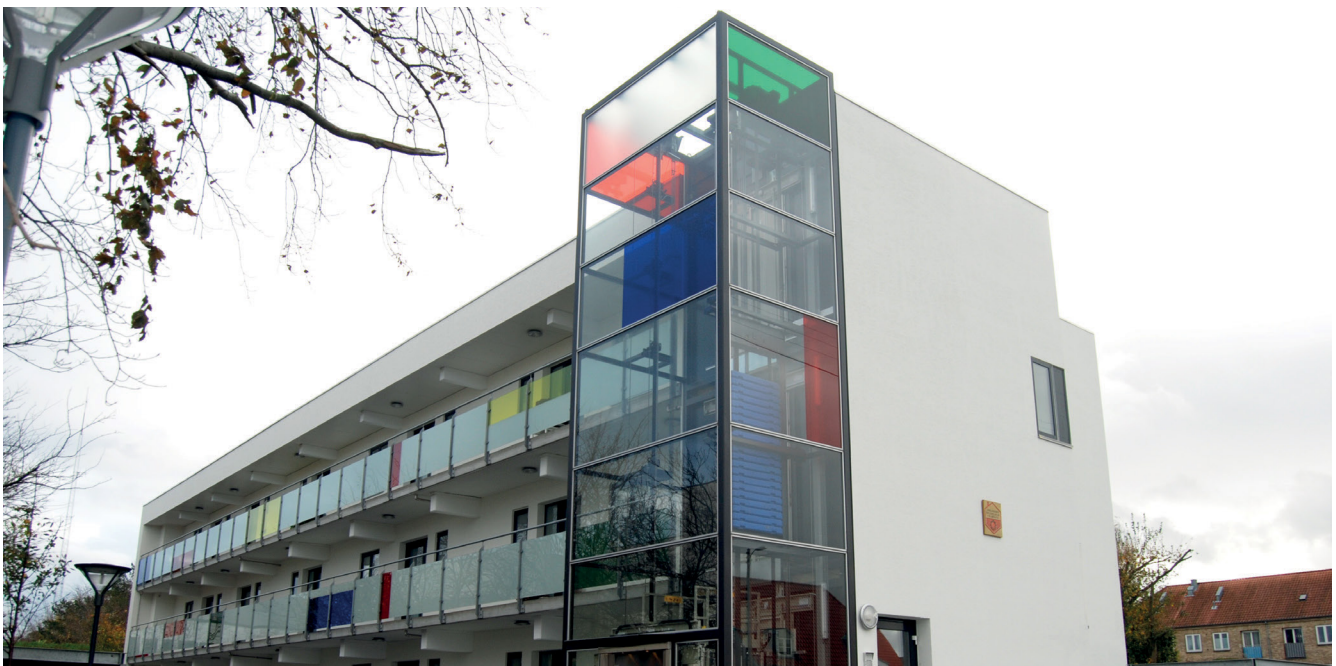
Udvendig facadeisolering med puds på ydervæg med både massive og hulmursisolerede vægge på ejendom fra 1970-71
