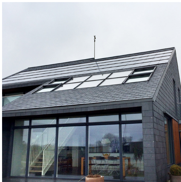
Vippevindue i tag til afkast af luft
