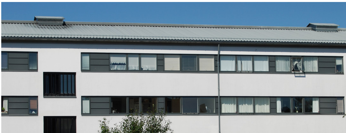
Udvendig facadeisolering med puds
