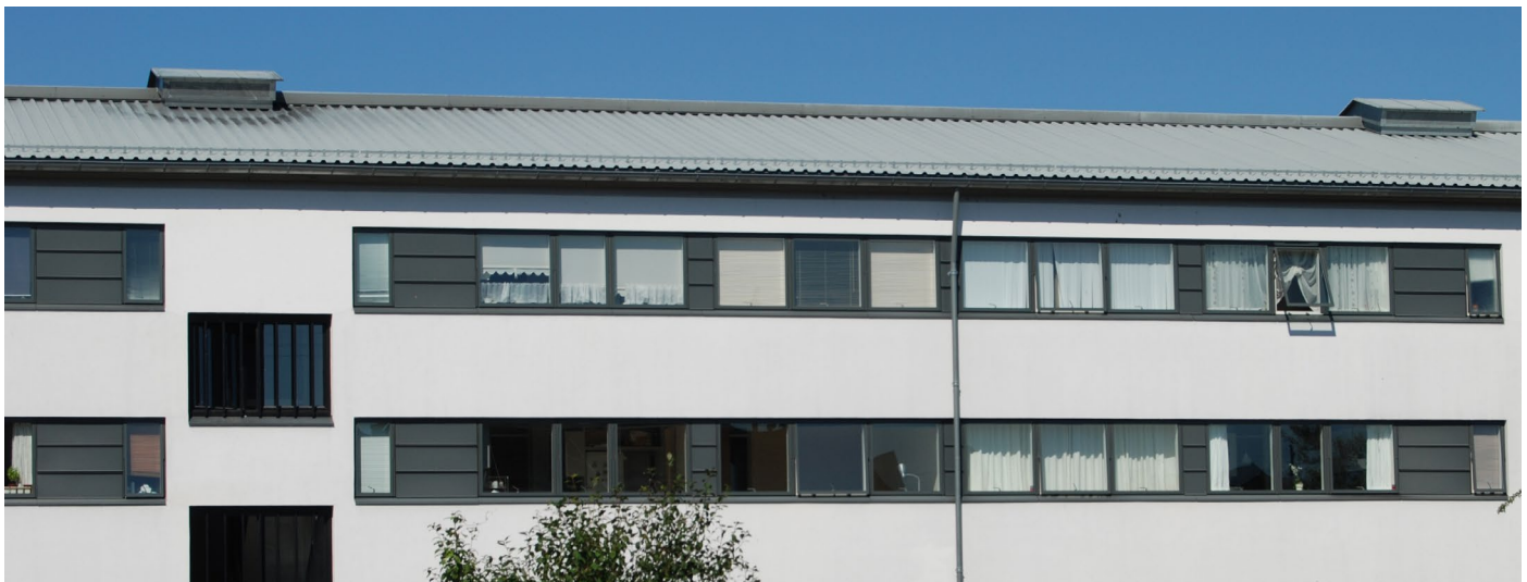
Udvendig facadeisolering med puds
