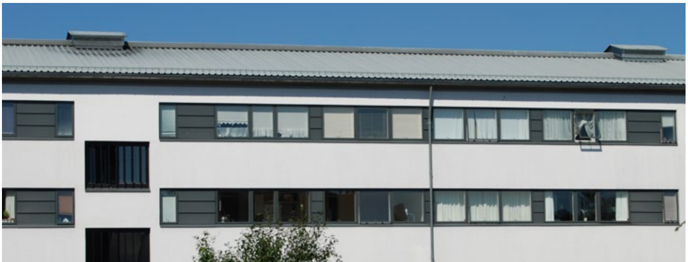
Udvendig facadeisolering med puds
