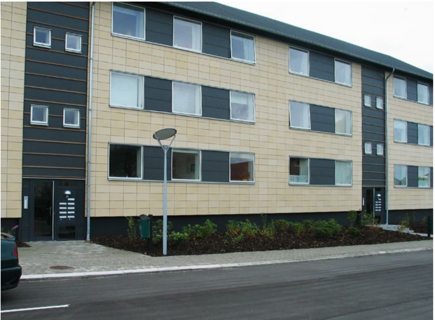
Udvendig facadeisolering med skærmtegl/fibercementplader
