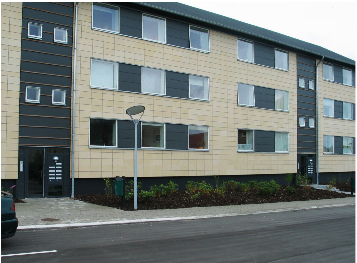
Udvendig facadeisolering med skærmtegl/fibercementplader
