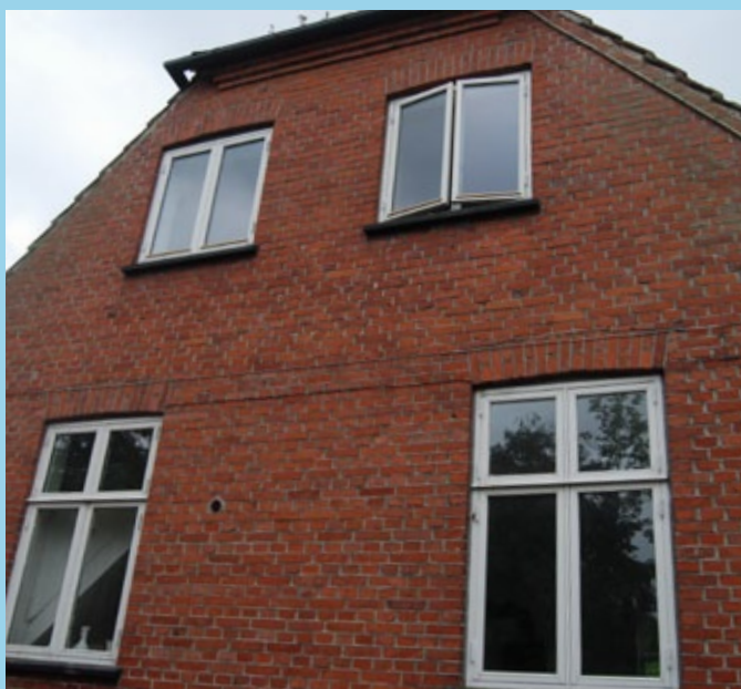
Øst-gavl med nye støjdæmpende energiruder i ekisterende vinduer
