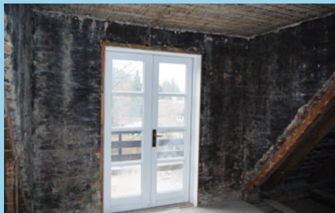
Eksisterende altandør i frontspids med nedrevne loft og cellotexplader
