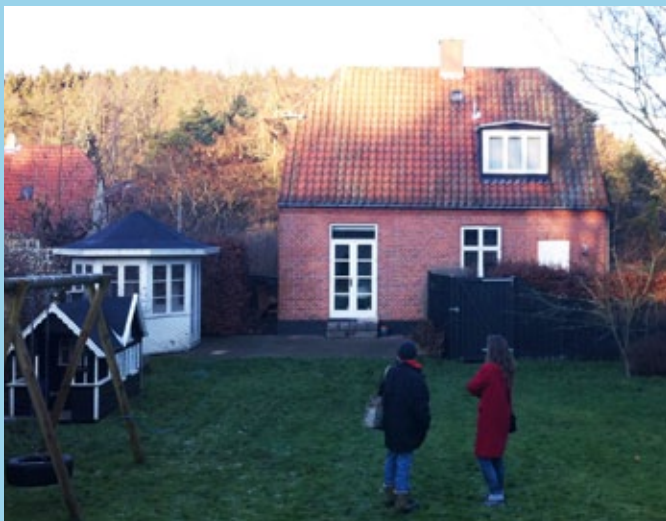
Huset fra havesiden før renovering - bemærk solen
