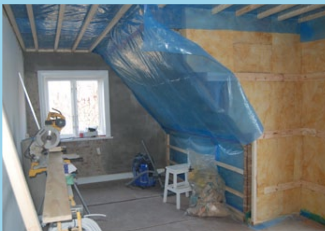
Efterisolering af skunk og skråvæg inkl. dampspærre samt indvendig efterisolering af frontspids
