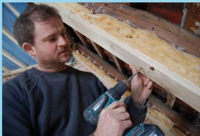
Forhøjelse af spær for plads til 150 mm isolering med \lambda = 32 på yderside af dampspærre
