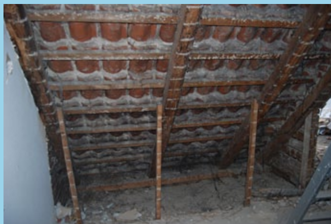
Skråvæg og skunk nedrevet
