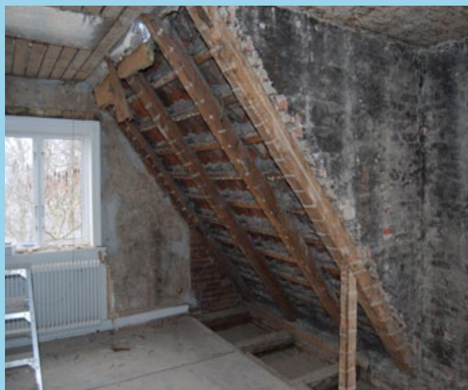
Loft samt skråvæg og skunk nedrevet. Indskudsler fjernet i bund af skunk og cellotexplader på gavl under nedtagning
