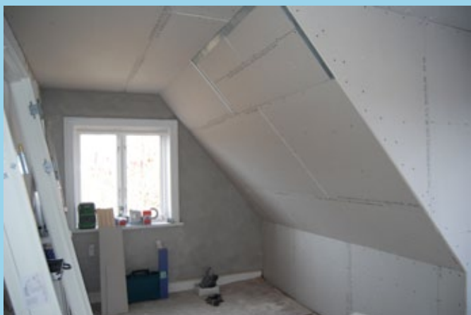
Efterisolering af loft, skunk og skråvæg samt frontspids skjult bag to lag gips
