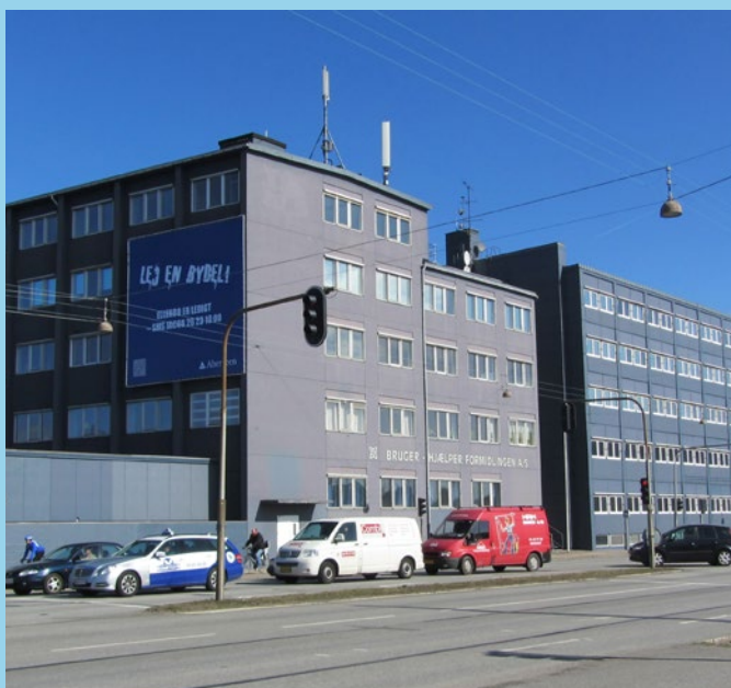
Bygningen før renovering
