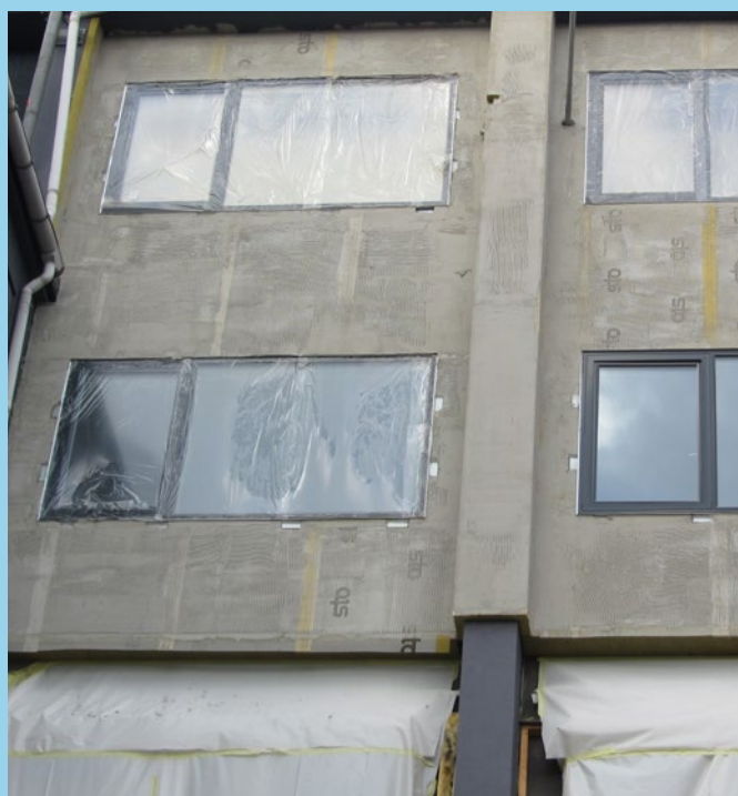
Udvendig efterisolering og pudsningsarbejde. Bemærk at isolering gennemføres for søjlerne også
