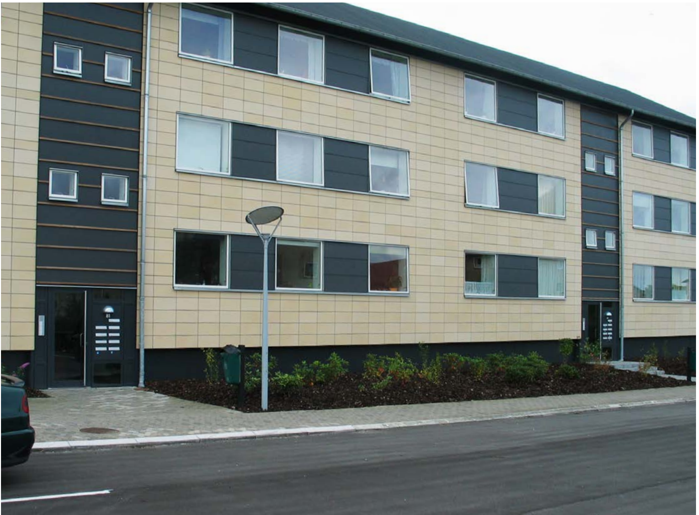
Udvendig facadeisolering med skærmtegl/fibercementplader
