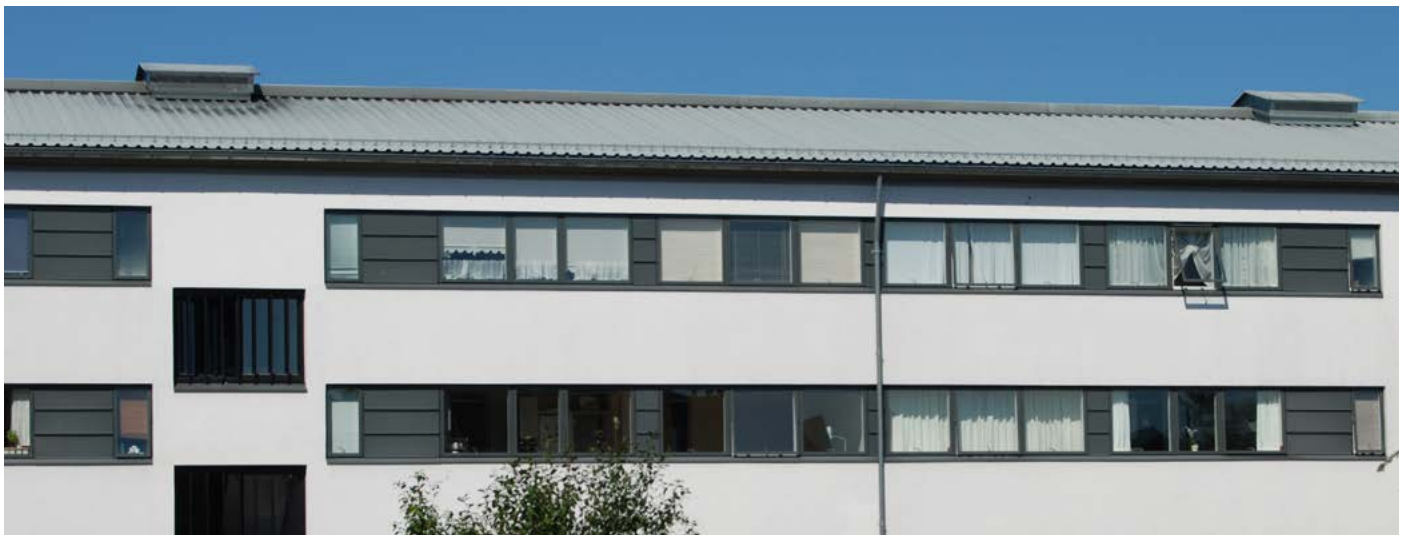
Udvendig facadeisolering med puds
