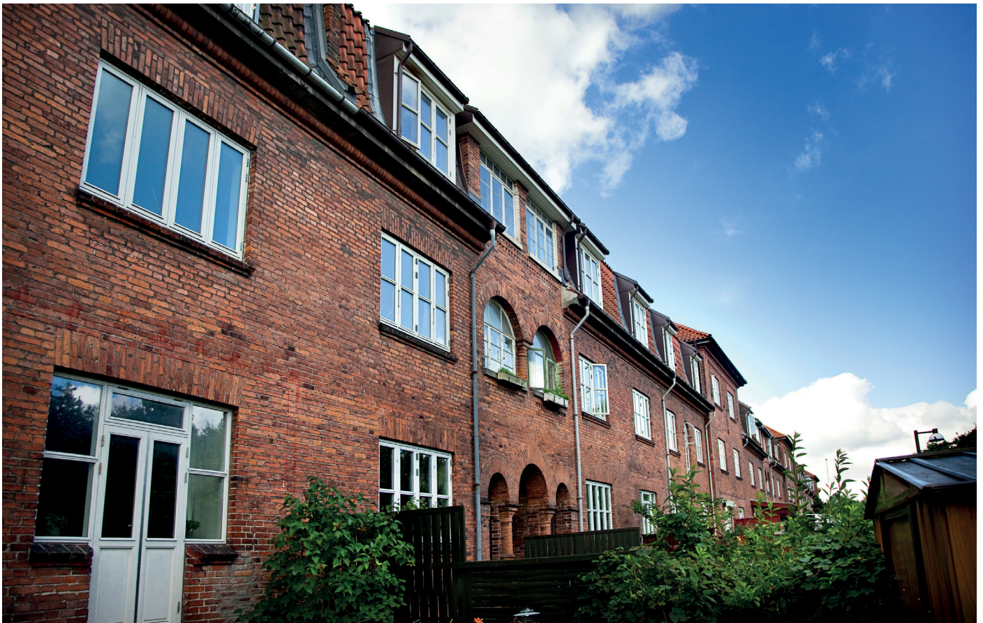
Fig. 14: Løsning 1 - Med anvendelse af eksisterende skorsten i stue til indblæsning + eksisterende aftræk i køkken/bad til udsugning.
